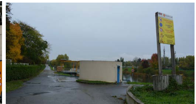
VILLAGE DES MÉDIAS, RÉSERVOIR D'EAU. 2022
